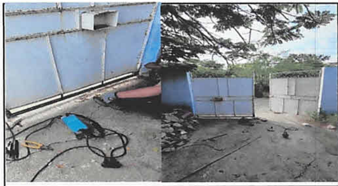
Reparación y mantenimiento de portón principal.
