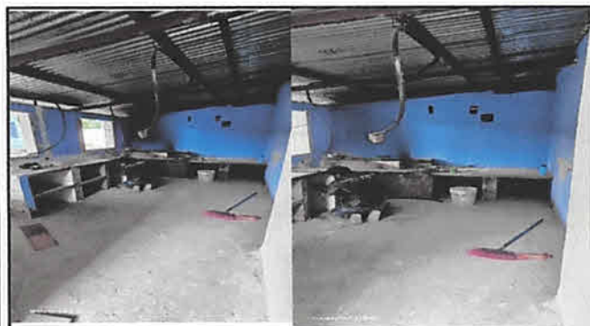
Reparación de Mesón.
