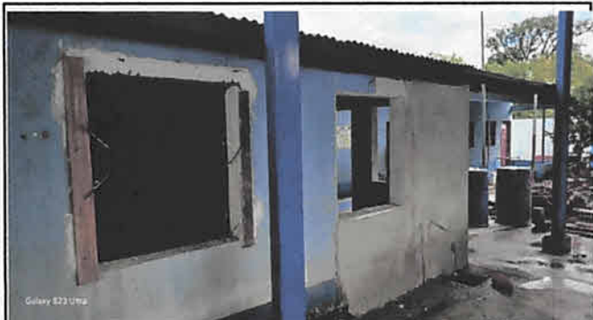
Demolición de pared, pila y levantado de pared.
